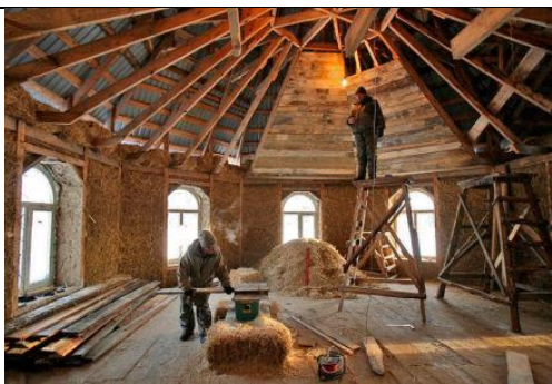
Рисунок 1 Строительство современного дома
